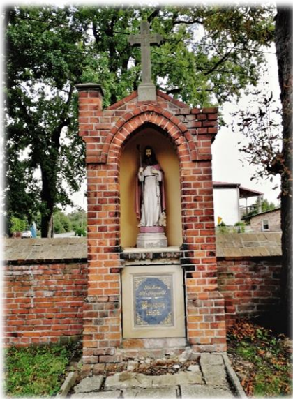
Kapliczka św. Idziego przed remontem
